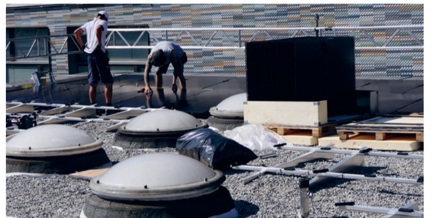
Die Dachlandschaft beim Paneleinbau.
