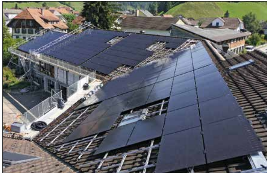
Über 1000 Panels wurden auf den Dächern installiert.
